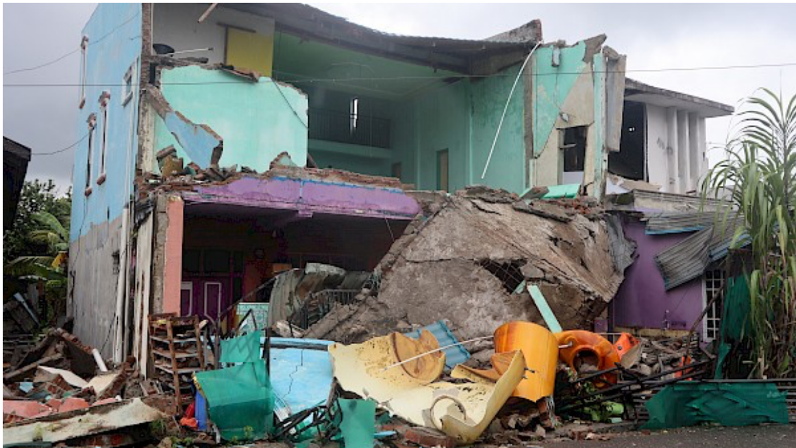
Von Erdbeben zerstörtes Haus in Westsulawesi, Indonesien
